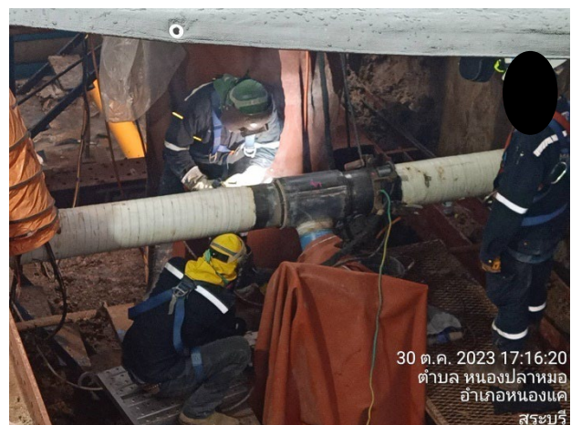
การสวมใส่อุปกรณ์ป้องกันอันตรายของผู้ปฏิบัติงานเชื่อมท่อก๊าซ
