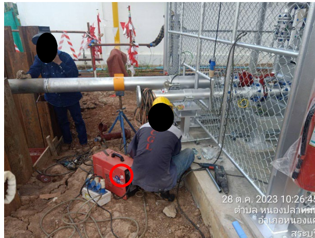
การติดตั้งสแต็คเกอร์แสดงการตรวจสอบสภาพของเครื่องเชื่อมท่อก๊าซ
