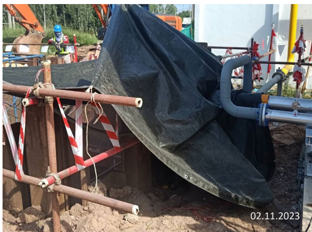
ข) การติดตั้งผ้าใบปิดกันโดยรอบ พร้อมติดป้ายบังคับต่างๆ
