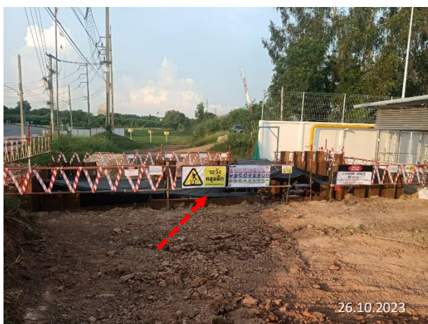
การติดตั้งแผงกั้นและเครื่องหมายเตือนบริเวณพื้นที่ทำงาน
