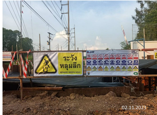
ข) การติดตั้งผ้าใบปิดกันโดยรอบ พร้อมติดป้ายบังคับต่างๆ
