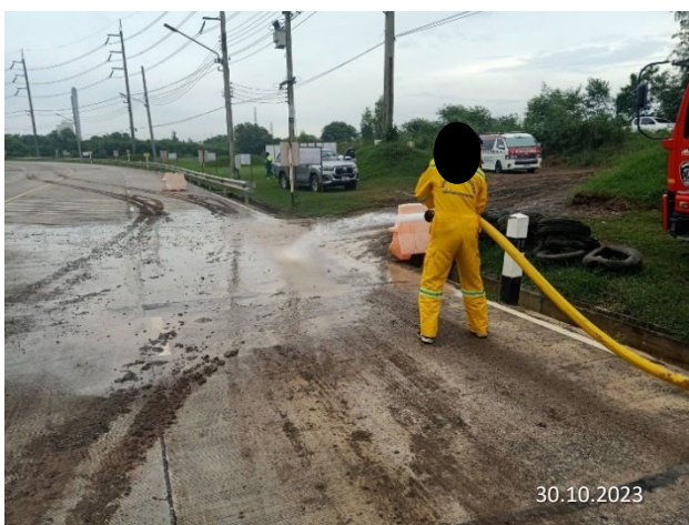
ค) การฉีดพรมน้ำและการทำความสะอาดเศษดินบริเวณ ถนนทางเข้า-ออกของโครงการ
