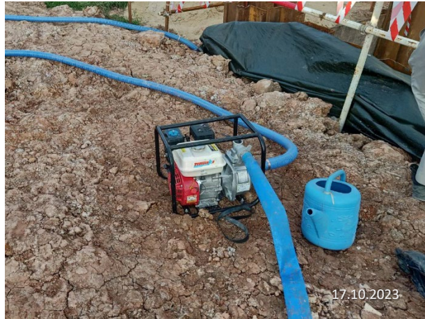
รูปที่ 2-13 การเตรียมเครื่องสูบน้ำแรงดันต่ำในพื้นที่ทำงาน
