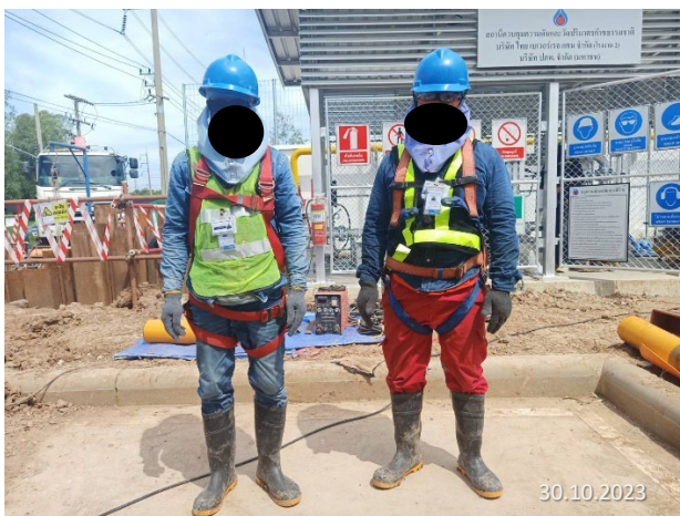
การสวมใส่อุปกรณ์ป้องกันอันตรายของผู้ปฏิบัติงานเชื่อมท่อก๊าซ
