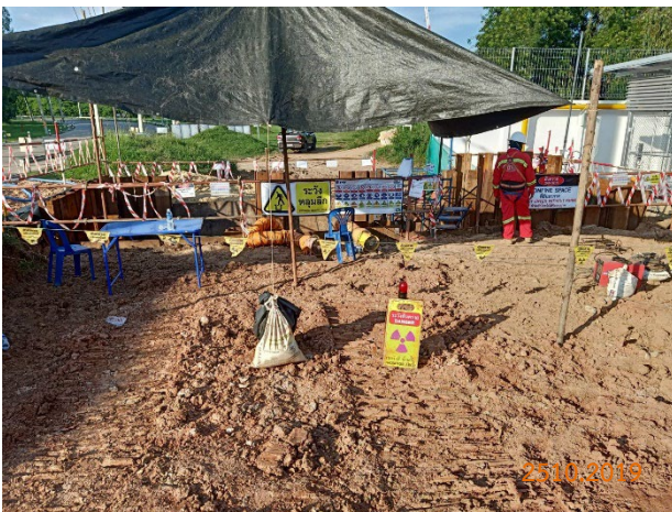
การกั้นเขตและการติดตั้งป้ายรังสีในบริเวณที่ดำเนินการตรวจสอบรอยเชื่อมด้วยรังสี รูปที่ 2-19 (ต่อ) การปฏิบัติด้านอาชีวอนามัย และความปลอดภัยของโครงการ
